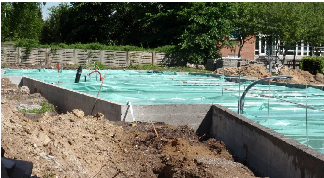
Figur 22. Byggeriet på 'En institution i Sorø' er påbegyndt. Foto: Hanne Ingversen, 22. maj 2014.
